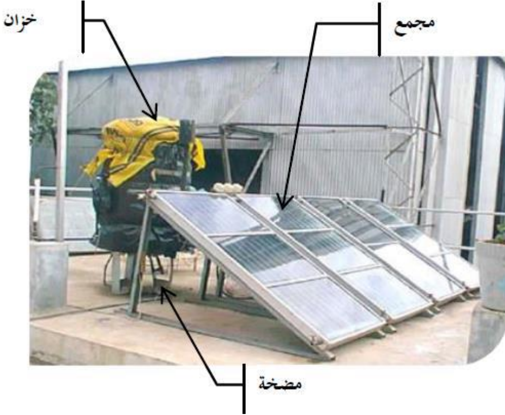
شكل رقم (10-2) سخان شمسي يعمل بوجود مضخة تسريع
