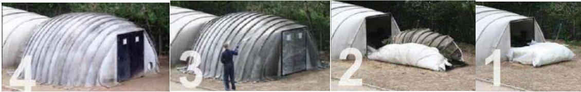
الشكل. (7_2) أربعة خطوات لتجهيز ملجئ إسمنتي من الأقمشة الإسمنتية [16]
