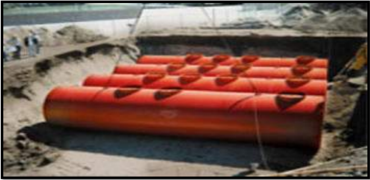
الشكل رقم ( ١١ ) يوضح وجود اربعة صهاريج او خزانات مياة مدفونة تحت الارض
