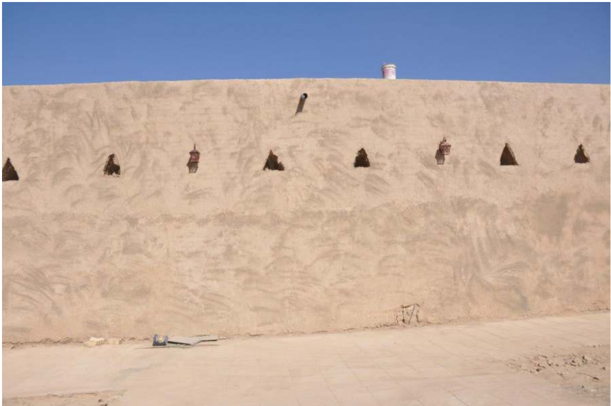
صورة رقم (٤) الجدار الجنوبي
