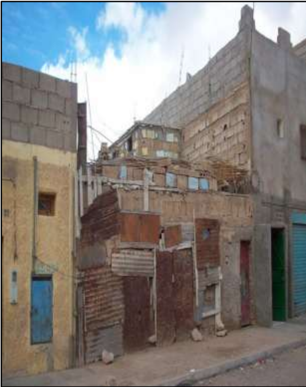
الصورة (11) البناء والسكن العشوائي في مدينة الحلة اطراف حي المهندسين
