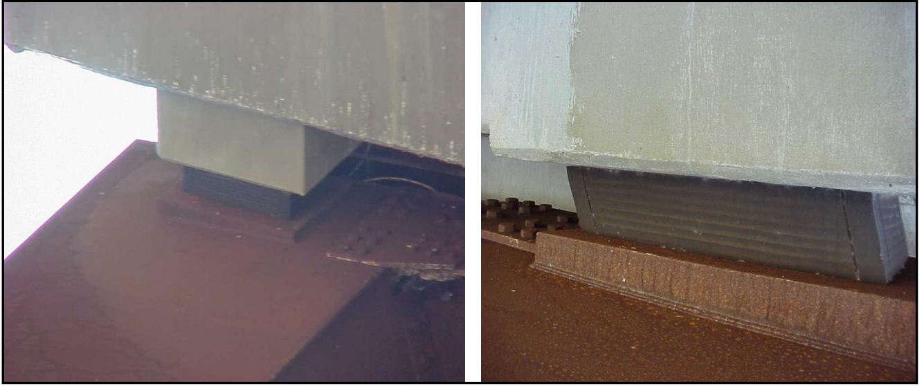
شكل رقم ( 1 - 1 ) يوضح الوسائد المطاطية في الجسور
