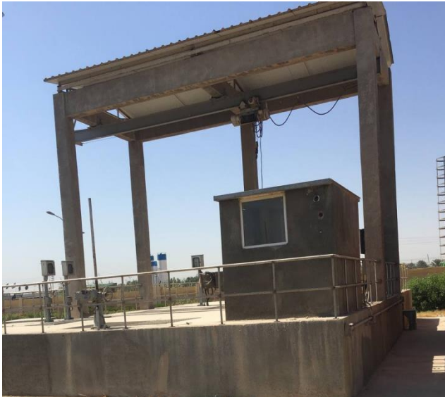
رفع المياه المعالجة
