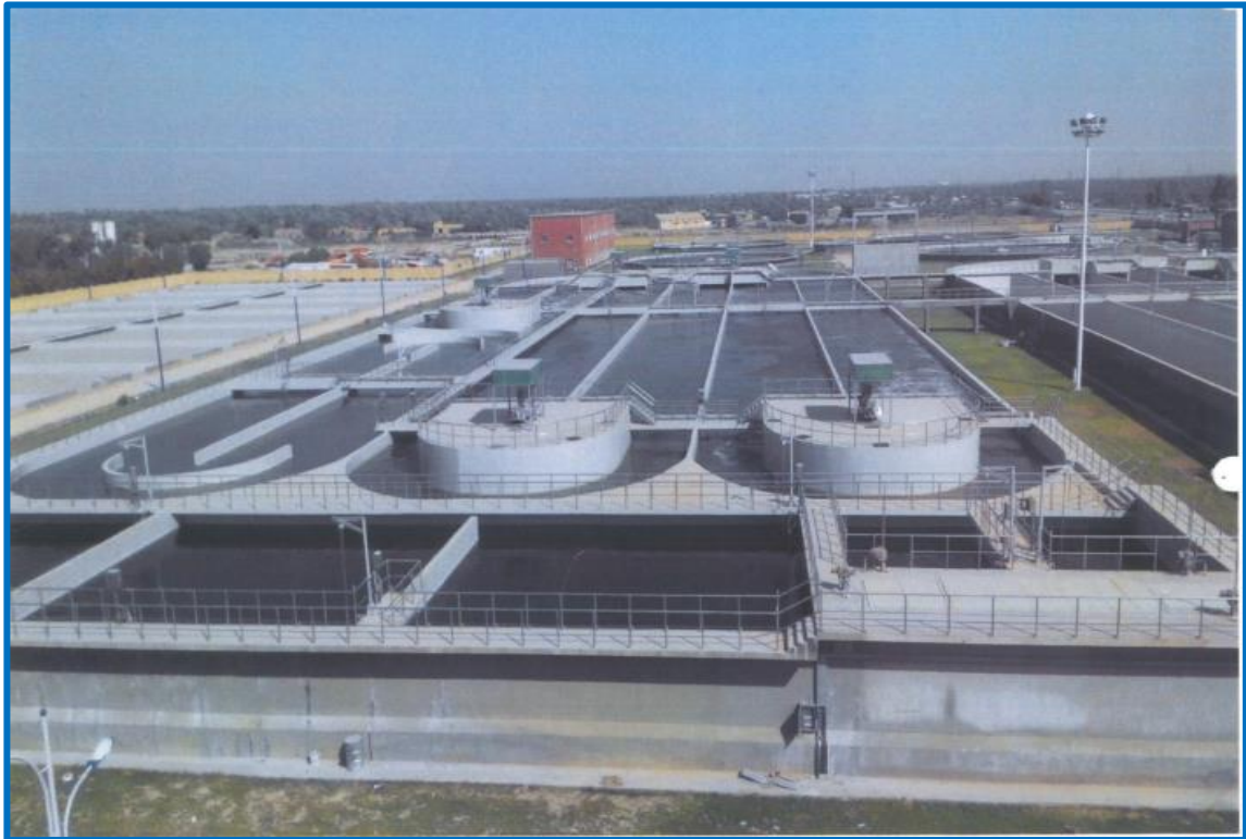
صورة (4) أحواض الأكسدة
