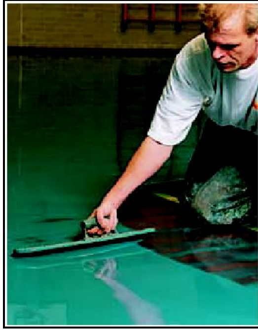
الشكل (2-14) يوضح سطح In Situ Polymeric والذي يتكون من طبقتين من البولي يورثان بسمك 1mm يصب انيا على سطح من المطاط المرن [86]
